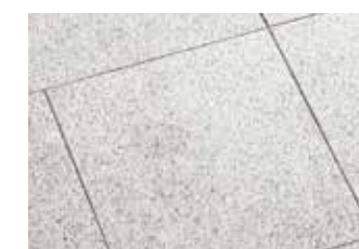
Dalle après le nettoyage avec CleanTop ®
