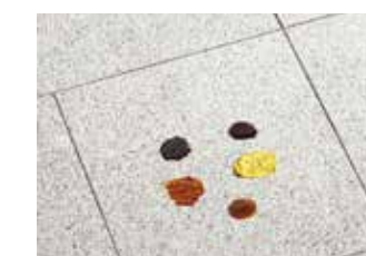
Dalle avant le nettoyage
